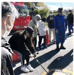
消火栓のふた開閉訓練
