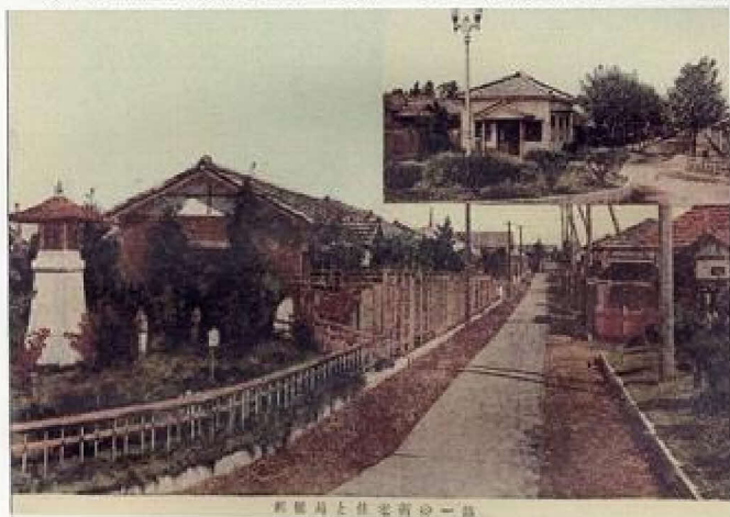
郵便局と住宅街の一部
