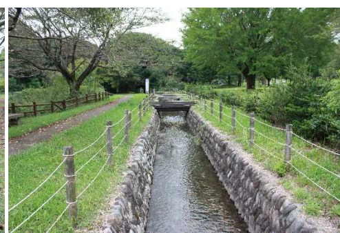
開渠の所は周りの景色に溶け込んでいます
